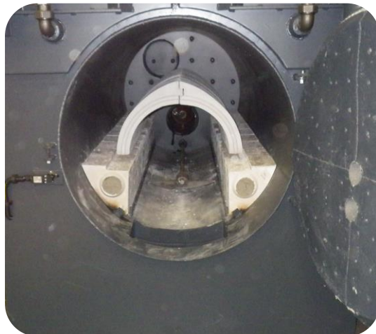
Åben fyrlågen og se efter opbygninger af aske/slagger
