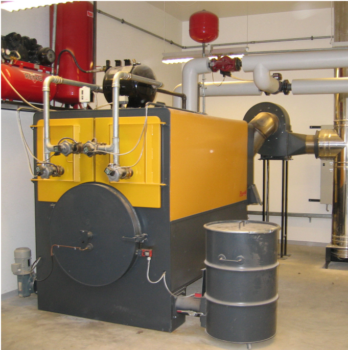
Kedelanlæg med stoker, cellesluse, snegl og tilbagebrandssikring. Askeudtag med 210 L tønde samt sodblæsning for røgrørsrensning.
